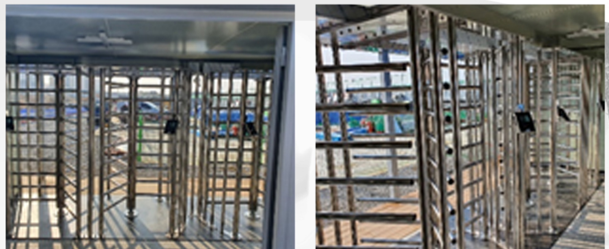
D 건설사 파주운정 현장
